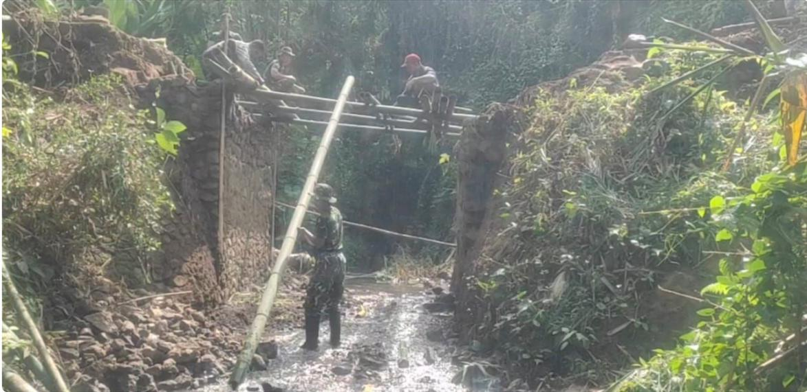
Menurut salah satu prajurit TNI anggota pasukan TNI Manunggal Membangun Desa (TMMD) Ke 117, bambu batangnya tidak mudah patah, sehingga batangan bambu dijadikan kerangka penyangga cor plat beton Jembatan tersebut.
